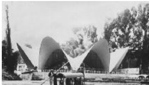
تصویر. Error! No text of specified style in document. ۱۷۴. استفاده از سهمی در معماری، رستوران مانانتیالز نمونه‌ای از کارکرد قوس به وسیله لای‌ای از بتن مسلح به ضخامت ۴ سانتیمتر، طرح سازه‌ی اثر فیلیکس کاندلا، ۱۹۵۸، (سنوزیان، ۱۳۸۹، ۴۸)
